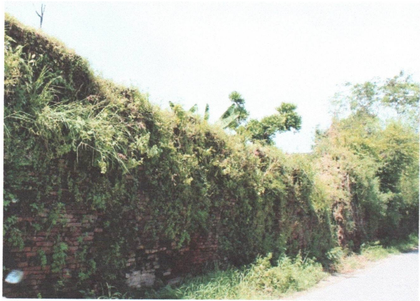
Gambar 7.17. Struktur Benteng Baluwarti Keraton Kartasura Sisi Barat ( Sumber: Dokumentasi TPCB Kabupaten Sukoharjo, 2022)
