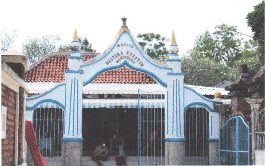
Gambar 7.7. Bangunan Masjid Hastana Karaton Kartasura yang terdapat di dalam situs (Sumber: Dokumentasi TPCB Kabupaten Sukoharjo, 2022)
