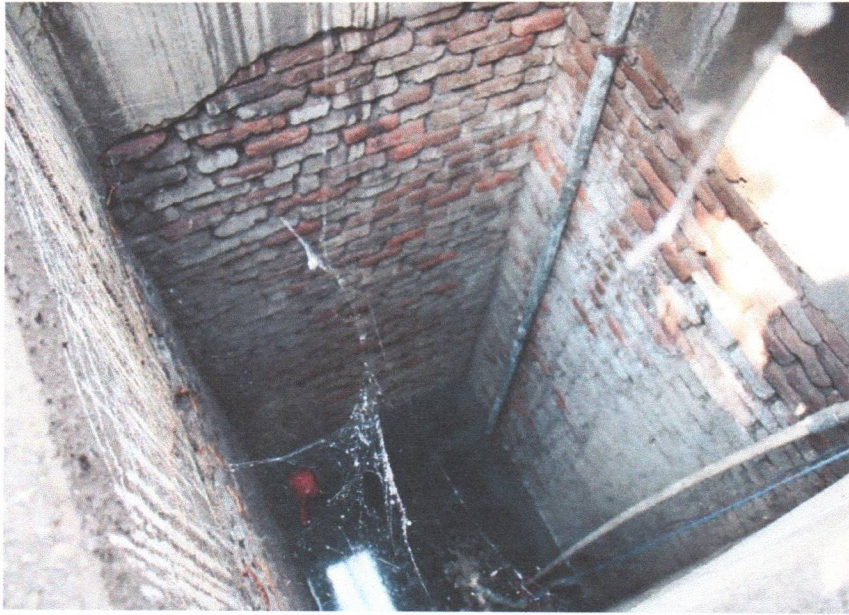
Gambar 7.12. Struktur Sumur Bandhung di dalam Situs (Sumber: Dokumentasi TPCB Kabupaten Sukoharjo, 2022)
